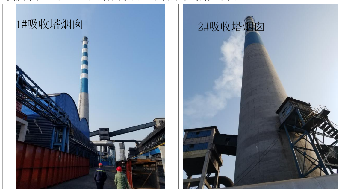
图 3-1 吸收塔排气筒现场照片
